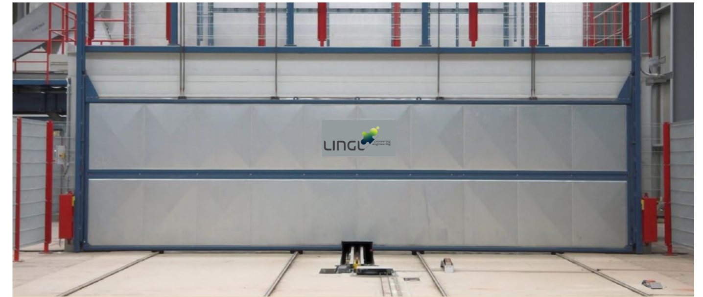
LINGL-Tunnelofen mit einer Länge von 176 m LINGL tunnel kiln 176 m long
