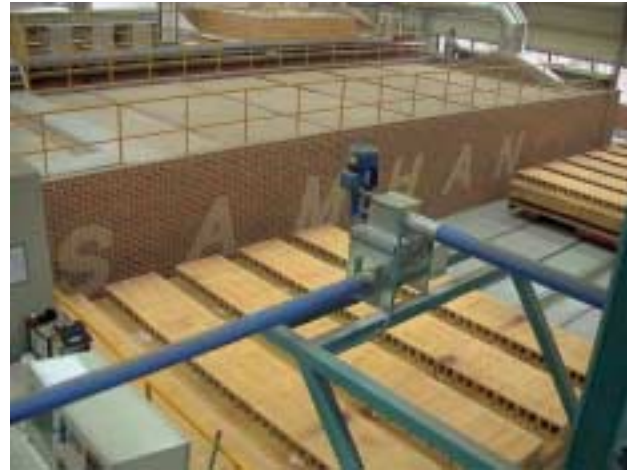
Bild 2: Blick auf den Vorwärmer mit dem Schriftzug „Sam Han C1“ Fig. 2: View of the preheater with the mosaic “Sam Han C1” logo
