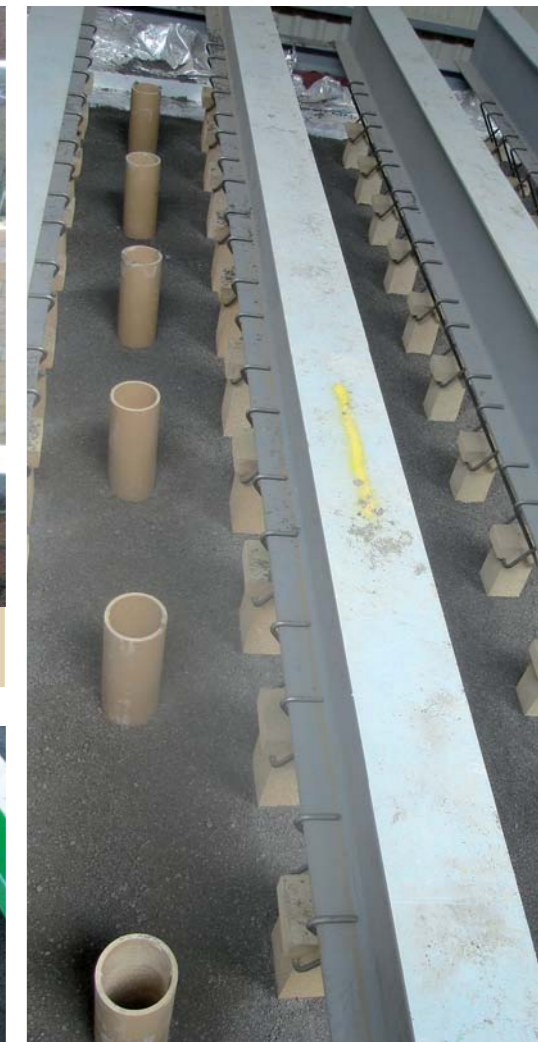
Deckenkonstruktion im Bau Roof design under construction
