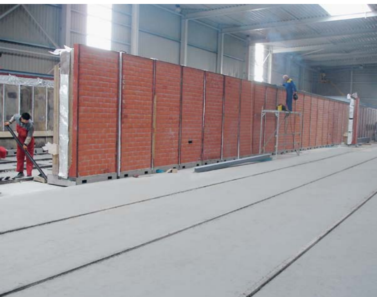
Modulofen – Aufstellen der Wandmodule Modular kiln – assembly of wall modules
