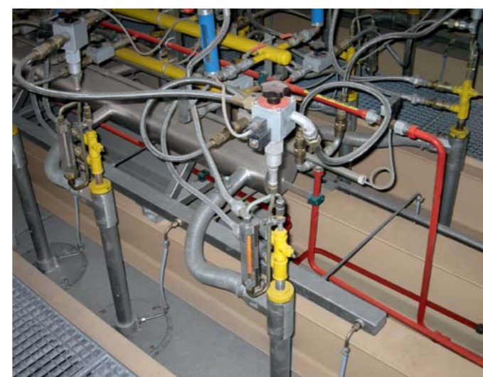
Dualbrennanlage für Pflanzenöl und Erdgas Dual fuel firing system for vegetable oil and natural gas
