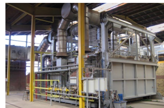
Shuttle kiln for face bricks Four à sole mobile pour briques de parement
