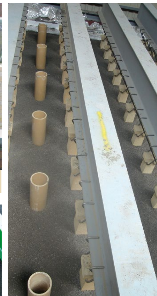
Roof design under construction Voûte en construction
