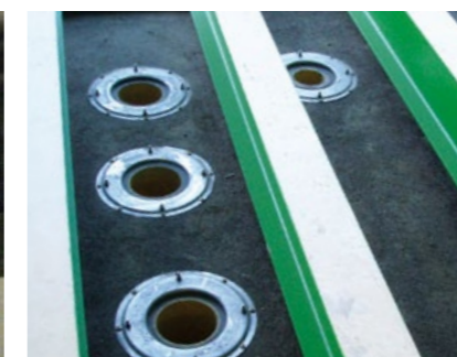
Finished open roof design Construction terminée de voûte ouverte
