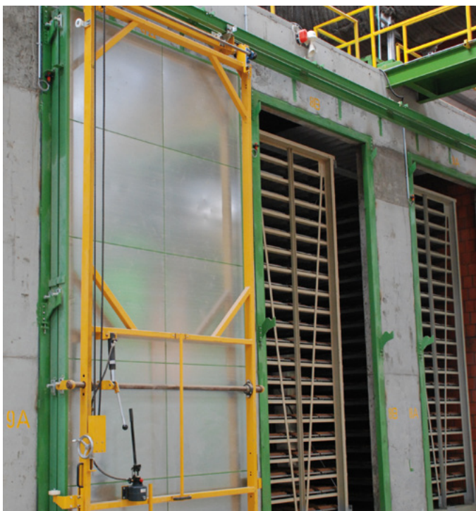
Séchoir à chambres Chamber dryer
